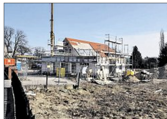
IM ROHBAU: Das Gastro-Landhaus der Bar Celona wird im Mai eröffnet und ist das erste in der Region. Foto: Wilde
